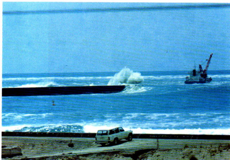
写真-17 南防波堤に衝突する第2列波。ガット船が必死に脱出しようとしている。岸壁上のワゴン車に注意。なお、第2列波沖合に砕波後の白い泡が残っている。天端高+3.5m。
