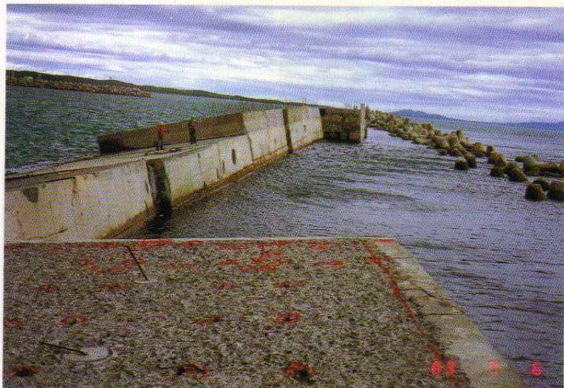
写真-21 D護岸ケーソン倒壊及び移動箇所
