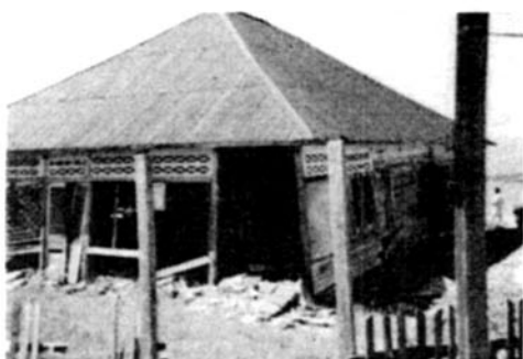
写真-2 津波によって破壊された家屋 (Bonebebakal 南部)
