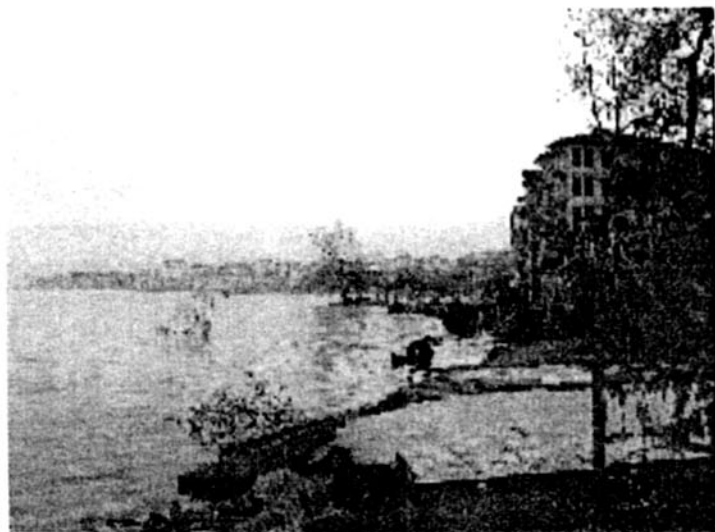
写真-3 デーレメンテレ沿岸における地盤沈下
