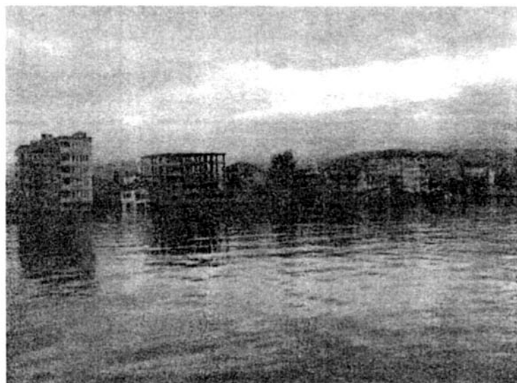
写真-2 ギョルジュク市内での沿岸（激しい地盤沈下が見られている）
