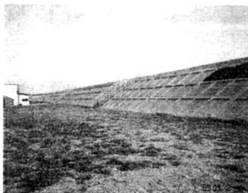
写真-5 長大な防潮堤—この付近で高さは11mもある
