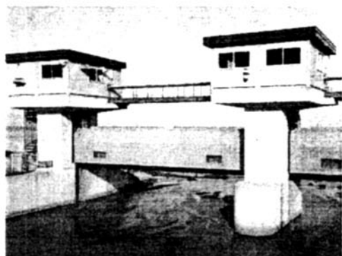
写真-7 津波水門—河川の河口より河川流域をまもる
