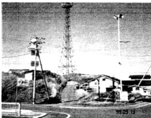
写真-13 青苗岬地区の三叉路—生死をわけた道
