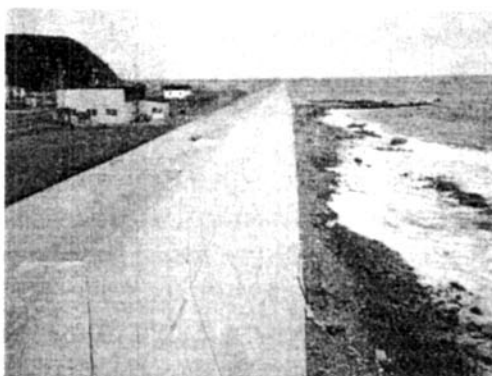
写真-6 防潮堤—初松前地区付近。住家のある区間はすべて防潮堤がある
