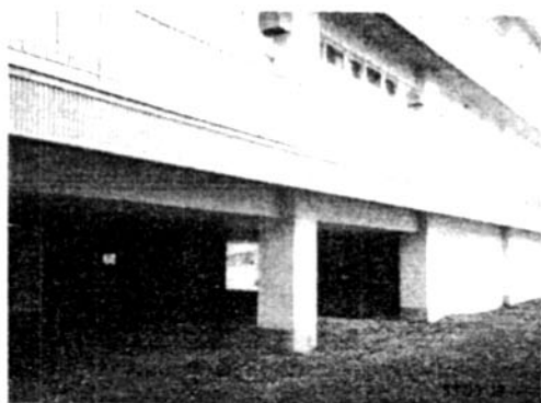
写真-8 青苗小学校の校舎は1階部分が空間(ピロティ構造)となっている
