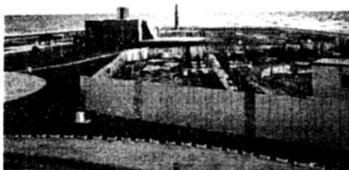
写真-18 青苗岬地区の津波館建設現場— 2000年秋頃にオープン予定
