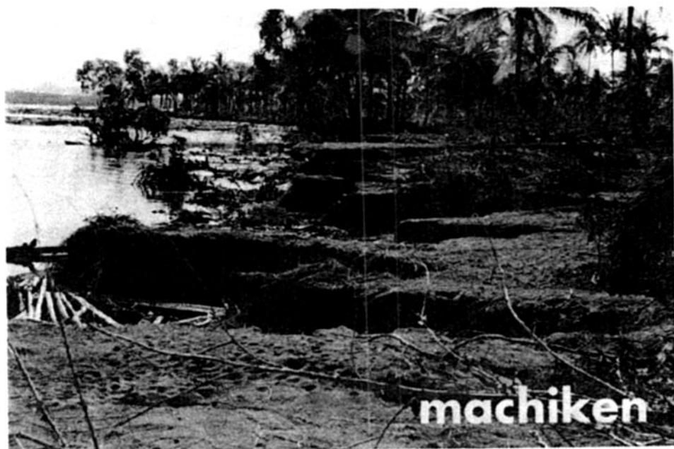
写真-4 砂嘴背後での侵食された様子
