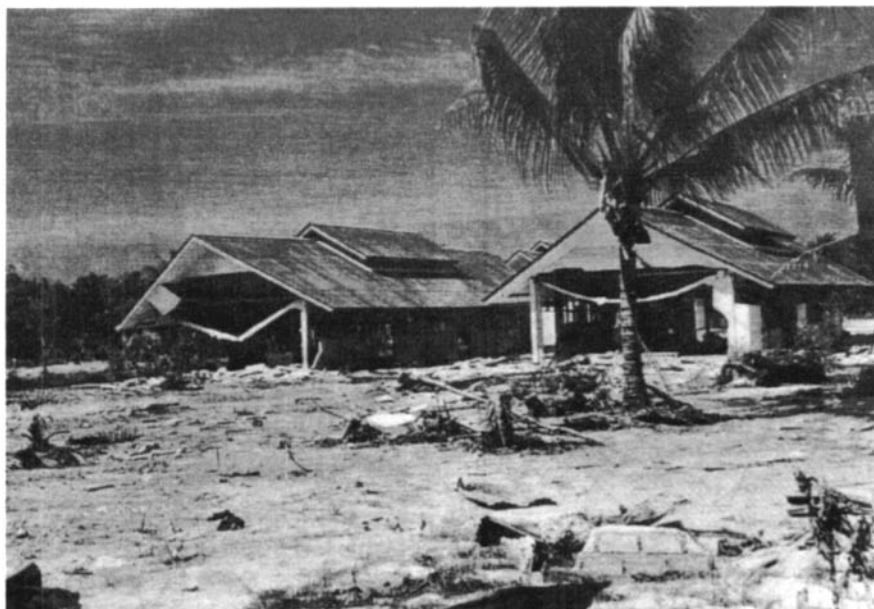
写真-7 Korimでの学校建物の被災状況
