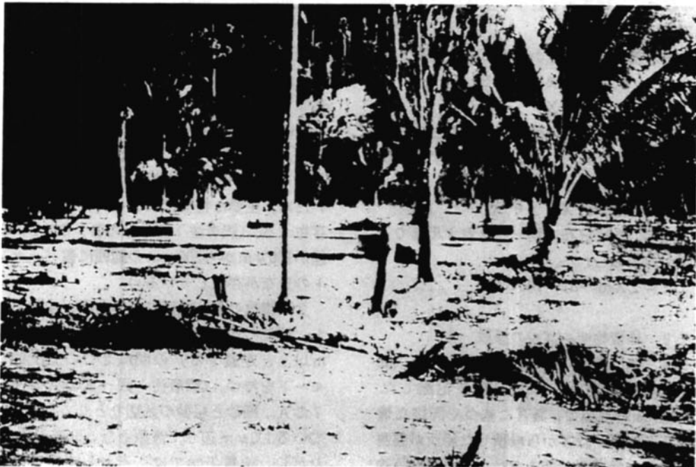
図-4 Rajegwesi村での破壊された集落。不連続な堆積物、流されたコンクリートブロックや木が見られる。(写真：S. Tinti氏提供)
