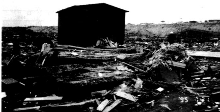
写真-2 青苗2区の西本商店土蔵。昭和初期に建設された。西側にある鉄の扉は水圧で変形し、高いところにある窓は破れたが、本体は完全に生き残り、中の物資も僅かな冠水に終わった。
