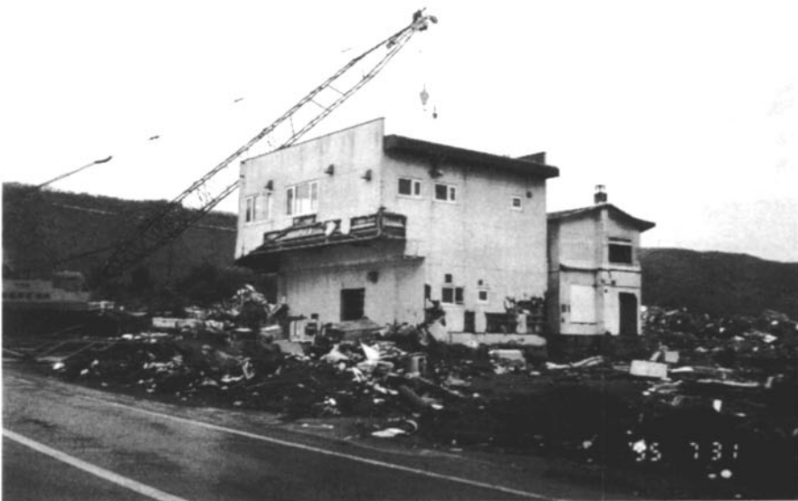
写真-5 青苗2区にある奥尻農協（左）と民家。農協は鉄骨粗にコンクリート・パネル貼り、民家はブロック造である。
