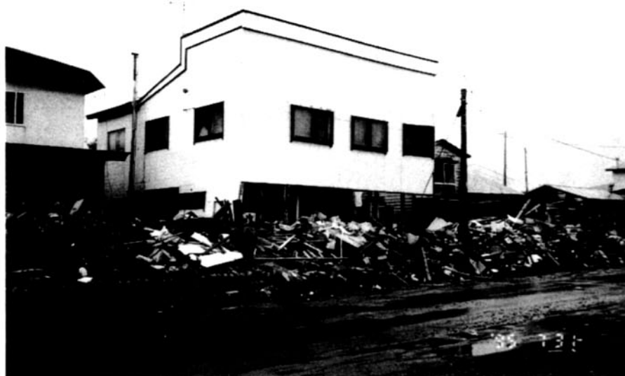
写真-7 青苗1区の大村家。道路に面した部分に柱と壁の少ない開放的な構造であったと思われる。道路に直接面しているだけ、下流側とは云いながら、渡辺家より不利であったとも云える。
