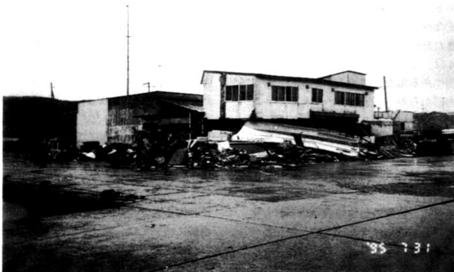
写真-3 奥尻漁協冷蔵庫。きわめて頑丈な造りで、内部の電源関係は浸水等の影響を受けたようであるが、本体は完全に生き残り、漁船3隻を押しとどめる効果があった。
