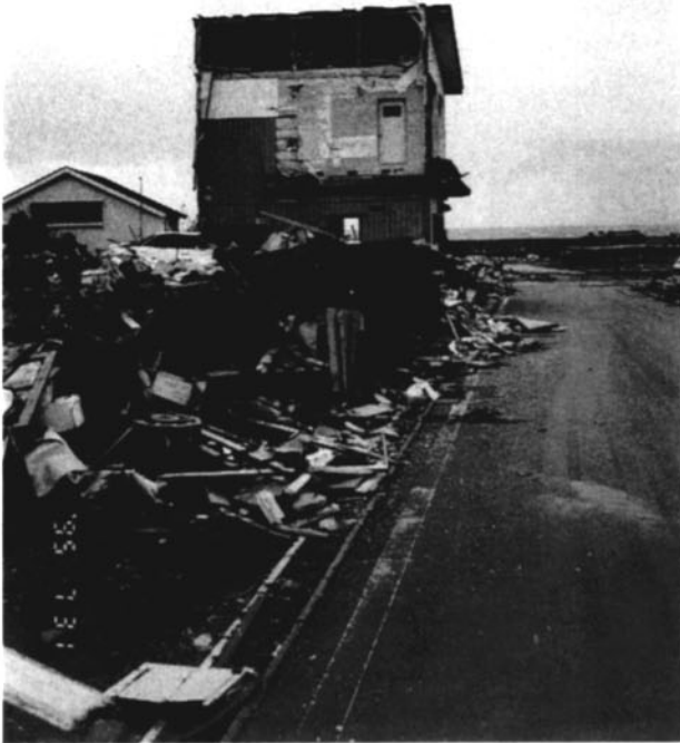
写真-9(3) 西側から見た鎌田家。一階の壁は残ったのに、二階の壁は無惨にはぎ取られた。
