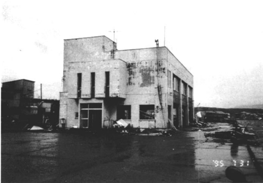
写真-4 青苗魚市場。一階の叩き部分は東西に吹き通しの腰高の建物で、南には部屋、北側はブロック壁となっていた。二階は事務所である。一階の部屋の窓は壊され、北側のブロック壁は外側へ倒されたが、そのほかは無傷で、二階は捜索隊によって使用されていた。
