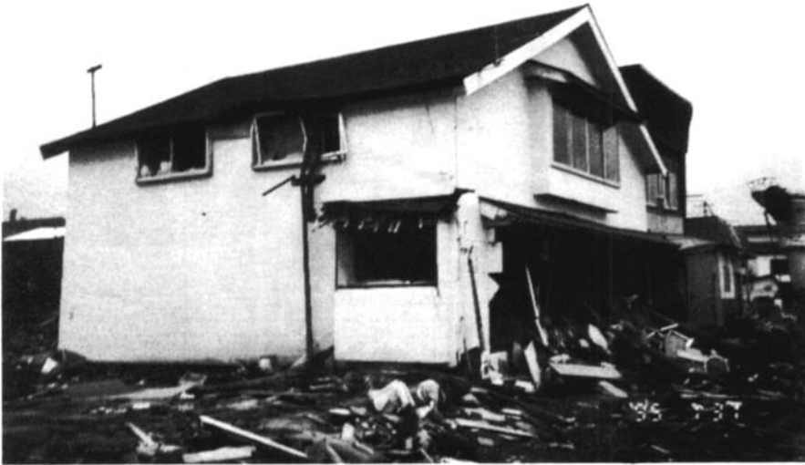
写真-8 青苗4区の関口家。室内で測られた浸水高は僅か40cmしかないのに、一階のみならず、二階の窓や屋根まで影響が及んでいる。右に少し覗いている漁船の高さなどから推察して漂流物の効果が大きかったものと思われる。
