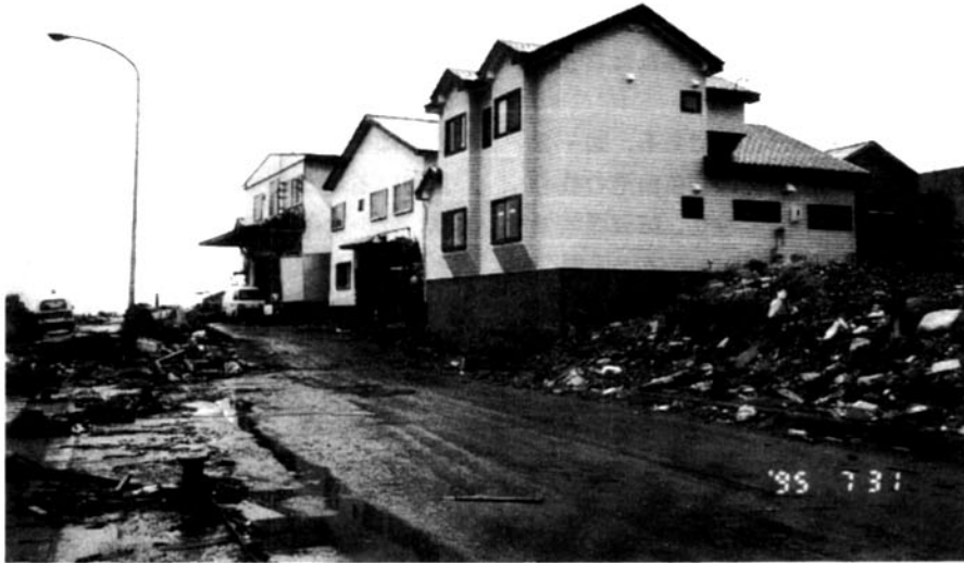
写真-1 青苗4区の宇宙家。岸壁のすぐ近くにあり、周囲が流失あるいは破壊されたにも関わらず、僅かな浸水にとどまった。
